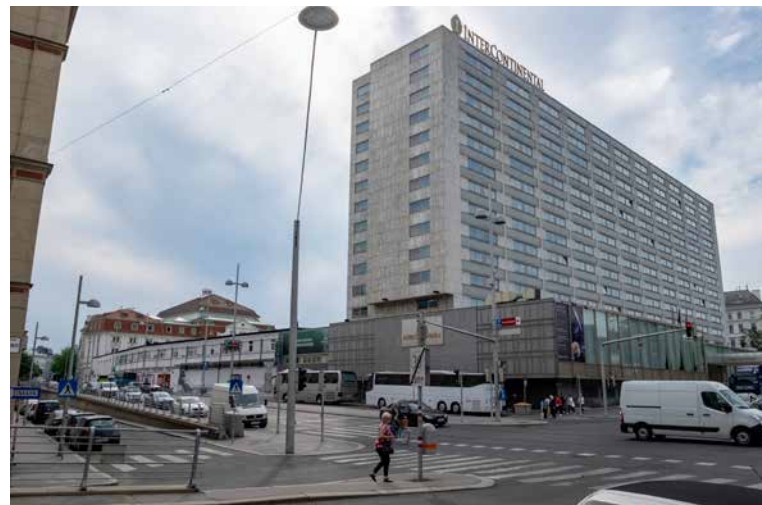
Abb. 6.9a,b,c: Derzeitige Situation Heumarkt-Areal, gesehen von der Johannesgasse, von der Straße Am Heumarkt, Situation zwischen Konzerthaus und WEV-Areal (© mkphc, Stadt Wien)
