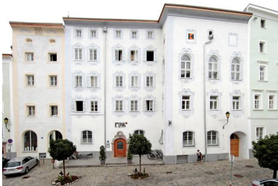
Ensemble am Schöndorferplatz in Hallein, Salzburg, Foto vorher: BDA, Foto nachher: Nikolaus Korab
