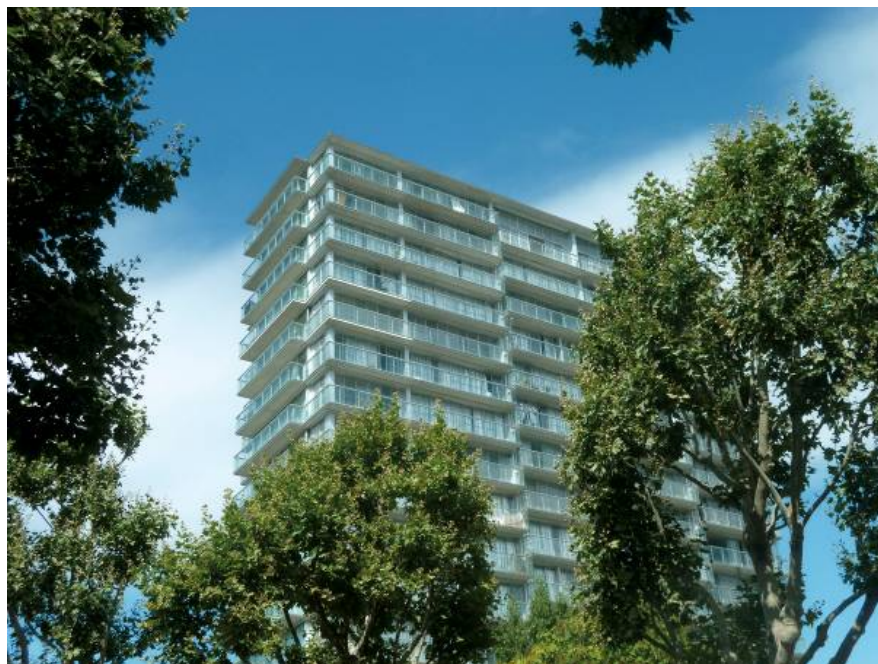
Wohnhochhaus im 17. Arrondissement in Paris, Fotos: Druot, Lacaton & Vassal
