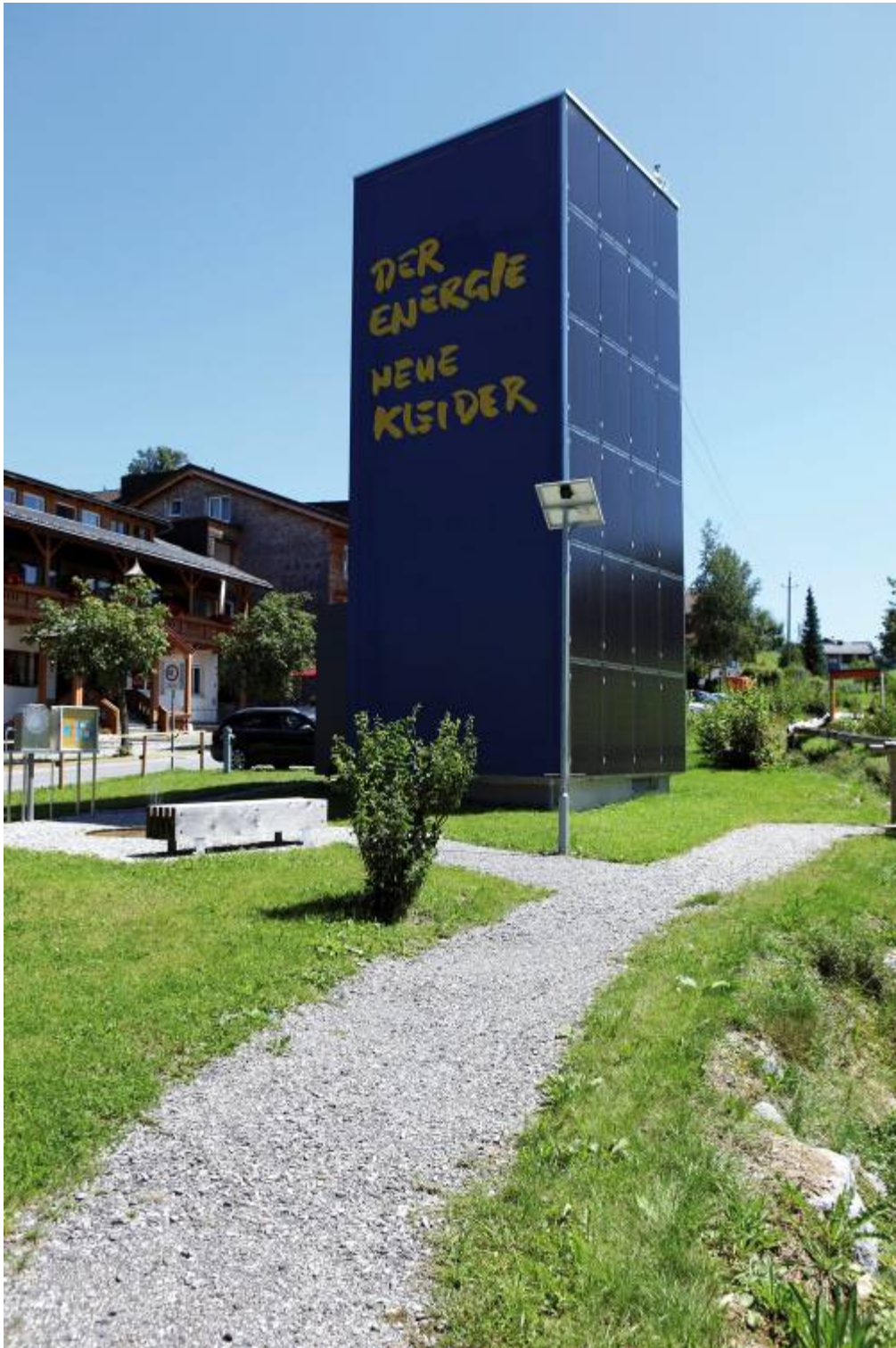
Umbau einer Trafostation zu einem Solar-Schaukraftwerk als Ausgangspunkt für den Energieweg in Langenegg, Vorarlberg (fink thurnher architekten, 2006), Foto: Roland Gruber
