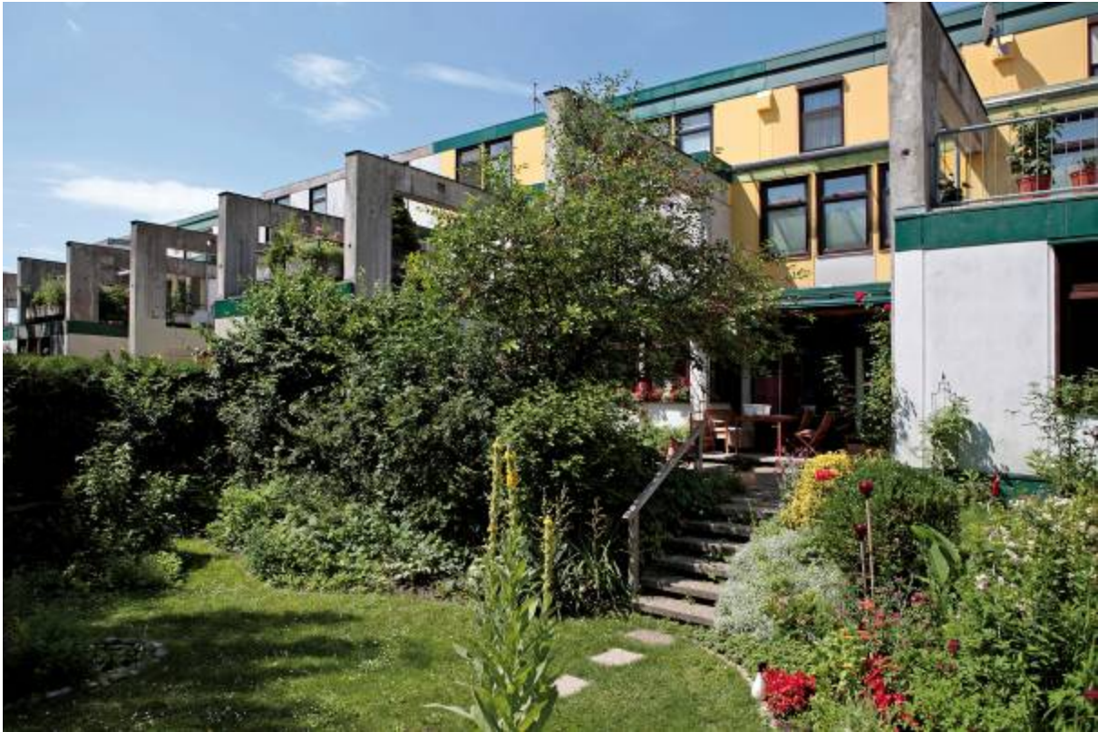
Das Wohnbauprojekt (1971 – 1976) in Hollabrunn von Ottokar Uhl war einer der frühesten partizipativen Bauten in Österreich, innovativ in der Erprobung vorgefertigter Bauteile und Resultat des niederösterreichischen „Wohnen morgen“-Wettbewerbs im Rahmen der Bundeswohnbauforschung.
