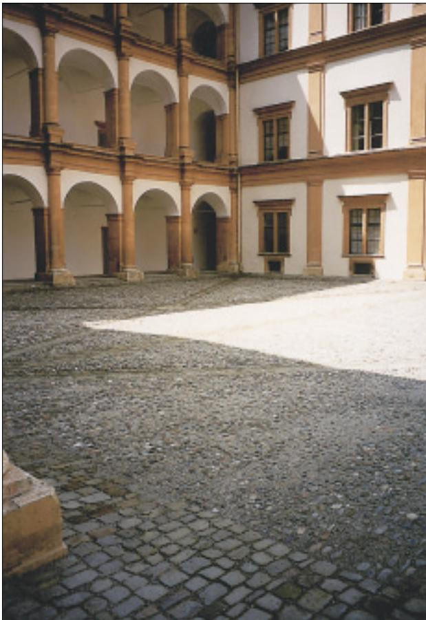
Abb. 2: Graz, Schloss Eggenberg. Innenhof nach Absenkung auf das ursprüngliche Niveau und Pflasterung mit „Murnockerln“
