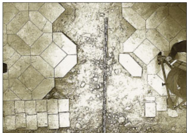
Abb. 2: Photogrammetrische Aufnahme des Kehlheimer-Plattenbelags im Kapitelsaal
