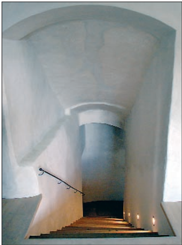
Abb. 3: Oetz, Turmgebäude, Gotisches Stiegenhaus
