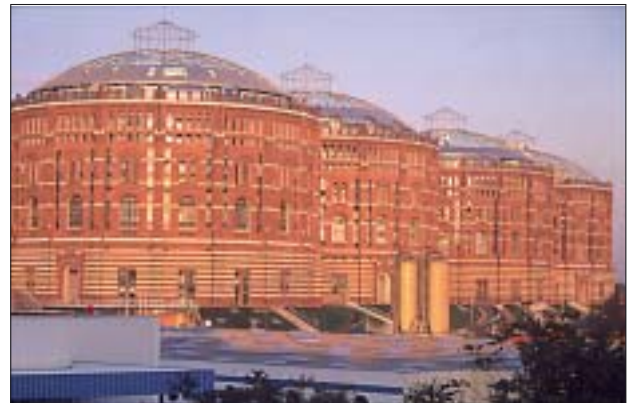
Abb. 1: Wien 11., Gasometer, nach Sanierung
