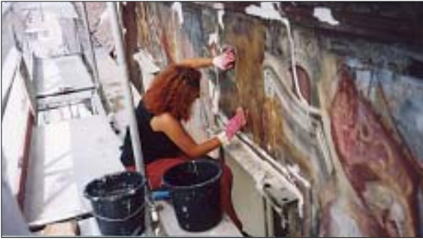
Abb. 3: Graz, Herrngasse 3, Gemaltes Haus, Reinigung, Festigung und Verkittung
