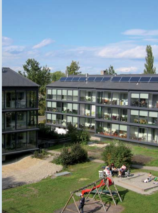
Energieeinsparung auf weniger als 10 % des ursprünglichen Verbrauchs. Wohnhausanlage Fussenau in Dornbirn, Vorarlberg Planung: Arch. DI Helmut Kuëss Foto: Architekturbüro Kuëss
